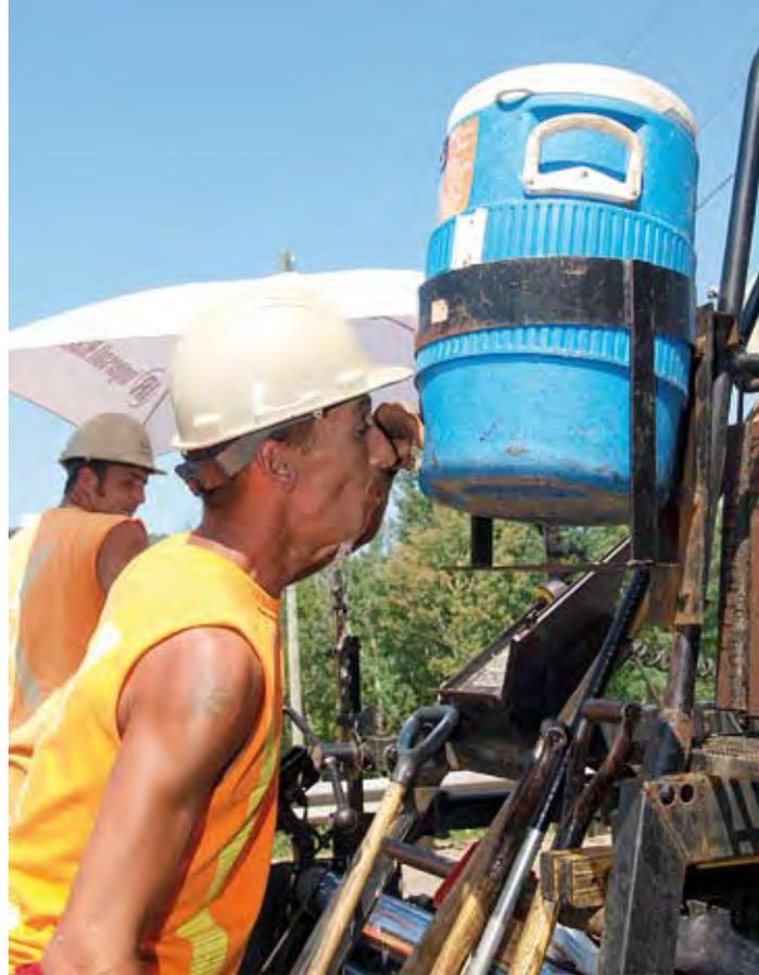
Au fil des ans, on a amélioré la machinerie et les travailleurs boivent régulièrement de l'eau pour s'hydrater. Afin de réduire l'exposition de ceux-ci aux vapeurs de l'asphalte, les paveuses sont dotées de cheminées et de ventilateurs captant et évacuant ces substances nocives.
