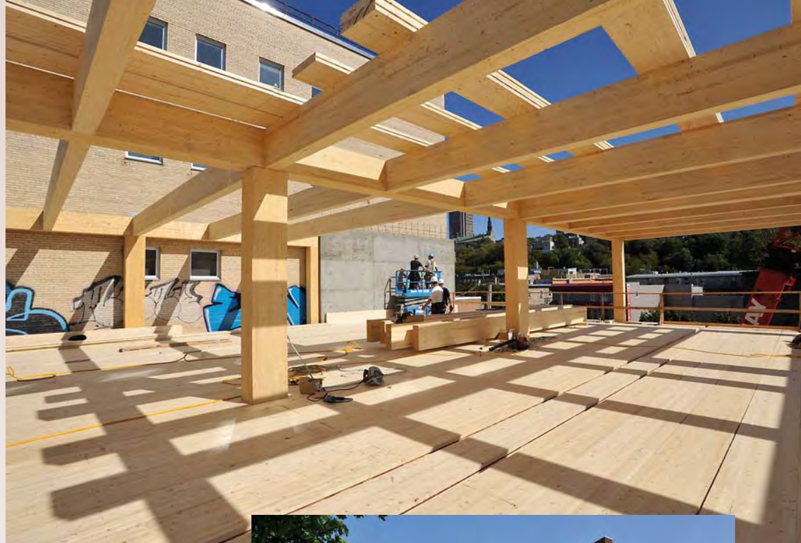
L'édifice est doté d'une structure de bois lamellé-collé.
