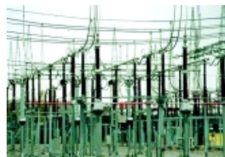
Des disjoncteurs et des sectionneurs fabriqués par les syndiqués d'Alstom à La Prairie.
