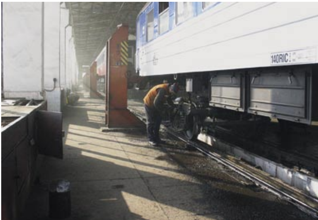
Un cheminot s'applique à visser les boulons des nouvelles roues installées sous les wagons d'un train qui arrive à Brest, première ville à la frontière entre la Pologne et la Biélorussie. Cette opération est essentielle car les rails de chemins de fer de toutes les anciennes républiques soviétiques sont plus larges que ceux utilisés en Europe. C'est une importante source d'emplois pour les travailleurs biélorusses.
