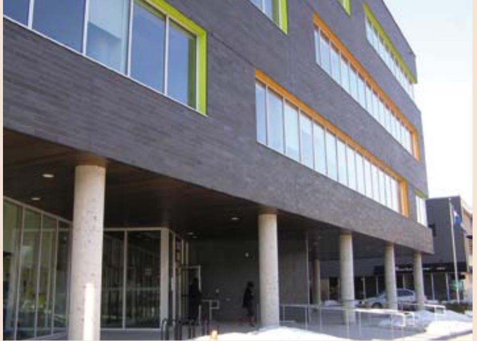
Le nouvel édifice abritant le CLSC Rosemont, situé dans le Technopôle Angus, est certifié LEED argent.
