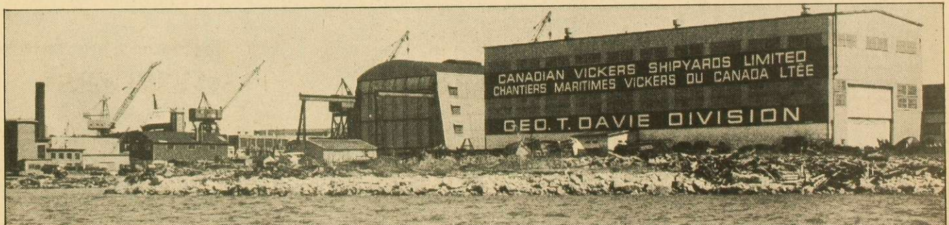
Le chantier de la George T. Davie and Sons, à Lauzon
